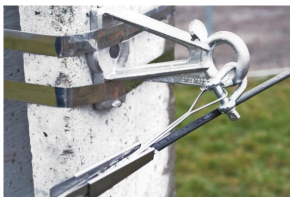
Sposób montażu szekli pomiędzy wspornik a uchwyt odciągowy
